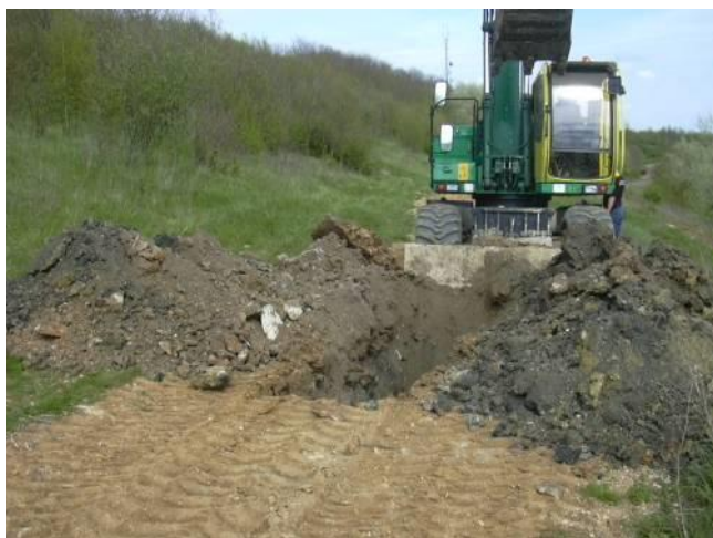
Réalisation d'un sondage à la pelle mécanique
