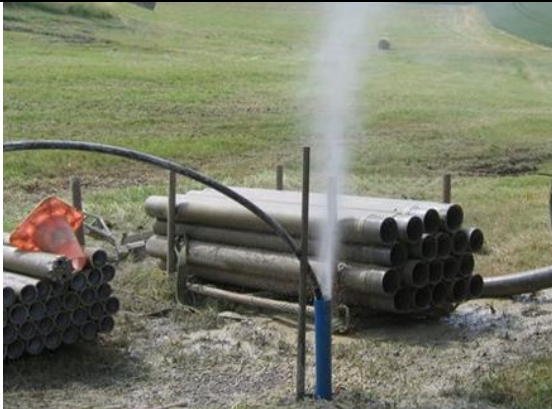
Développement par Air lift
