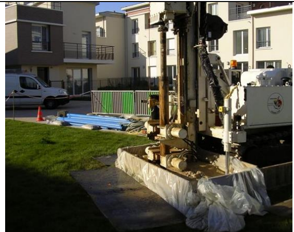
Installation du tubage provisoire
