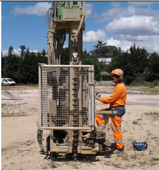
Forage à la tarière mécanique
