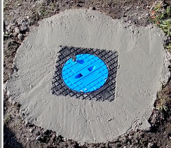
Mise en place de l'étanchéité et bouche ras du sol pour protection
