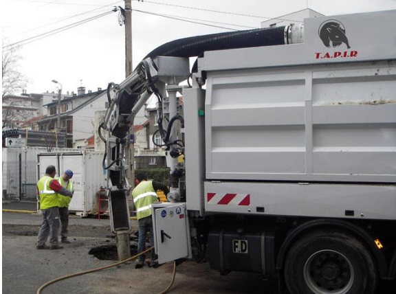
Réalisation d'une pré fouille
