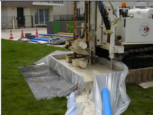
Foration du piézomètre au tricône à l'eau avec tubage provisoire
