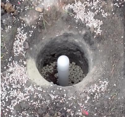
Equipped du sondage en gravillonnage, bentonite, tube PVC plein et crépiné à la profondeur souhaitée
