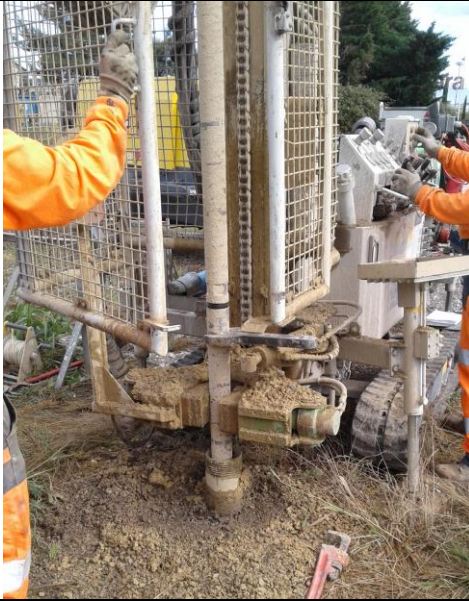
Mise en place du tubage provisoire
