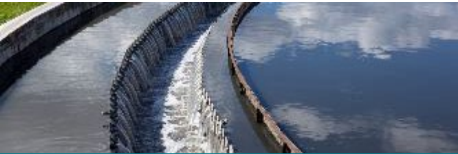
Eaux résiduaires urbaines et industrielles traitées
